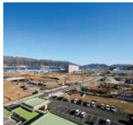
大船渡プラザホテルの駐車場（手前）の周辺では㈱キャッセン大船渡が運営する施設整備が進行中です
