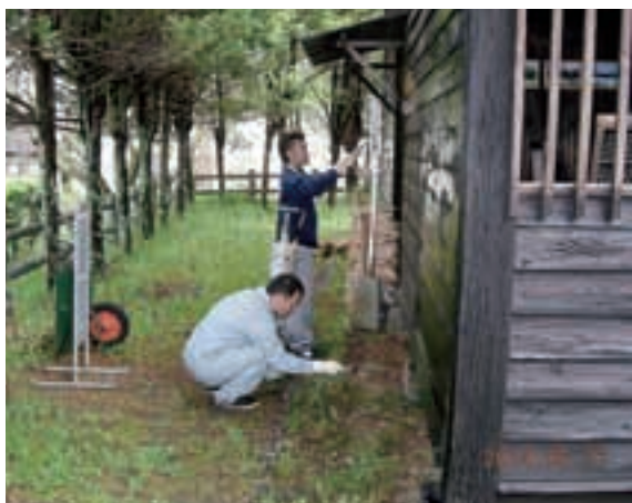
旧洪民尋常高等小学校外壁塗装活動
